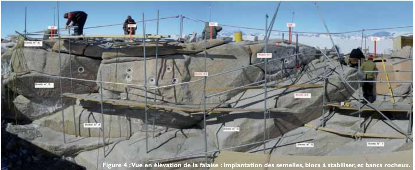
Figure 4 : Vue en élévation de la falaise : implantation des semelles, blocs à stabiliser, et bancs rocheux.
