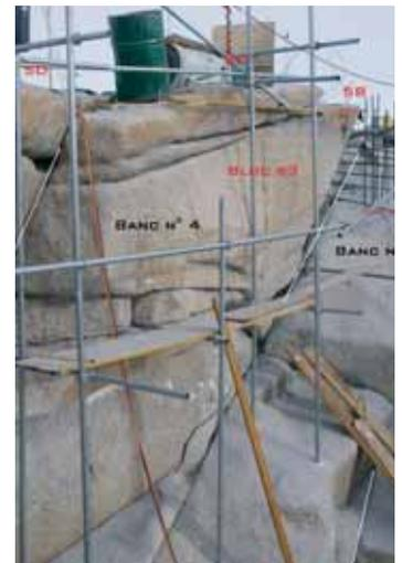
Figure 5 : Bancs rocheux, famille principale de fracture du massif, et bloc b3.
