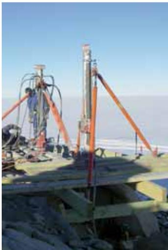
Figure 3 : Échafaudage pour faciliter la fixation des mâts de forage sur l'éboulis.
